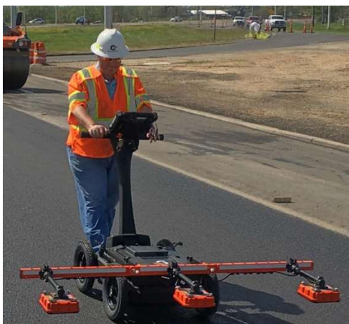
Fig.1 PaveScan®による舗装密度測定
